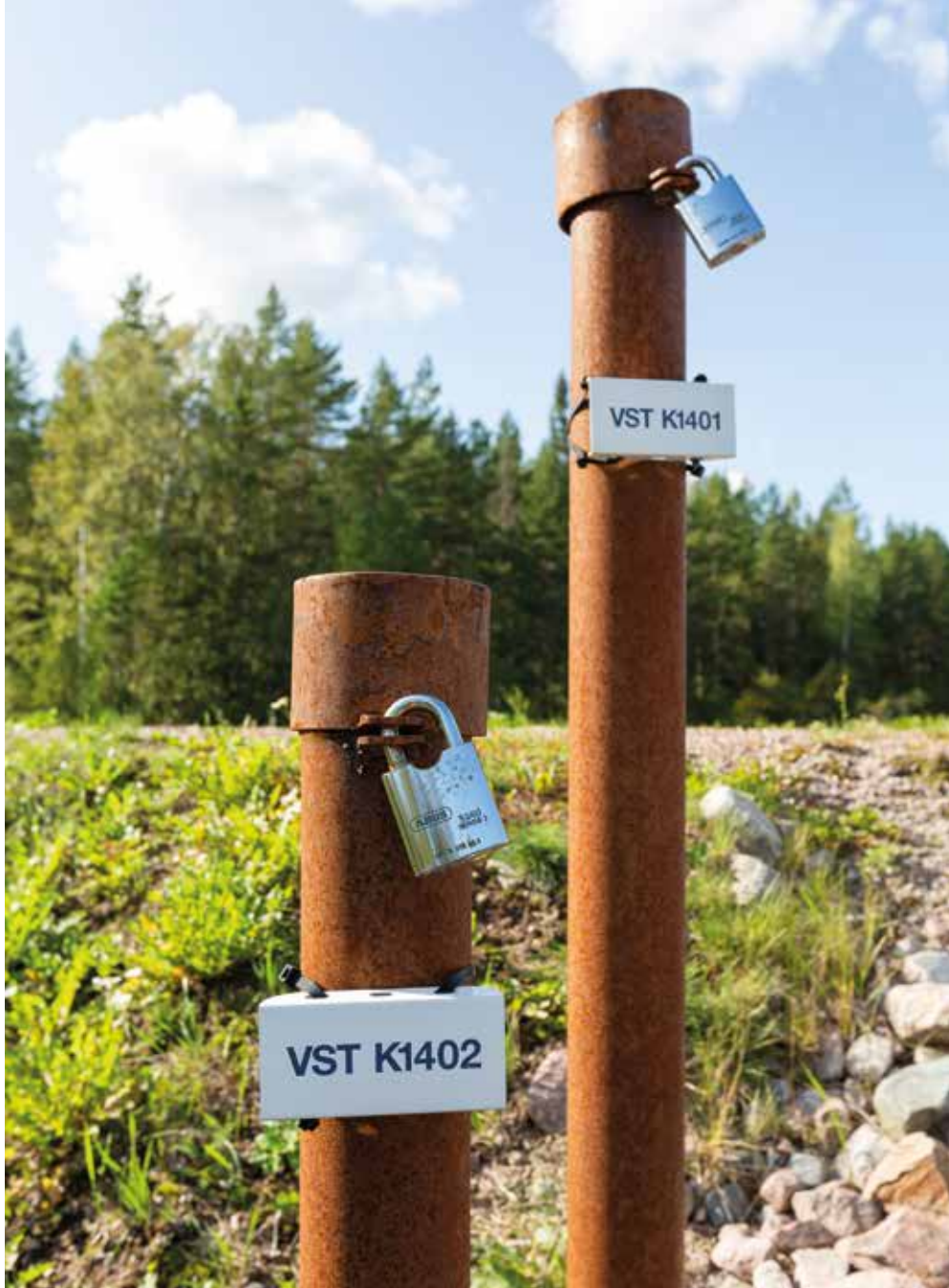
Vattenståndsror som nyttjas vid driftövervakning av dammkropp.
