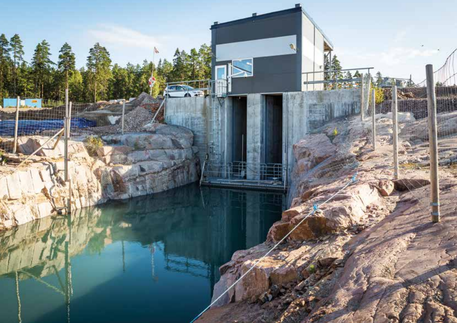
Utskovskonstruktion vid Ryllshyttemagasinet gruvdammanläggning i Garpenberg, Boliden AB.
