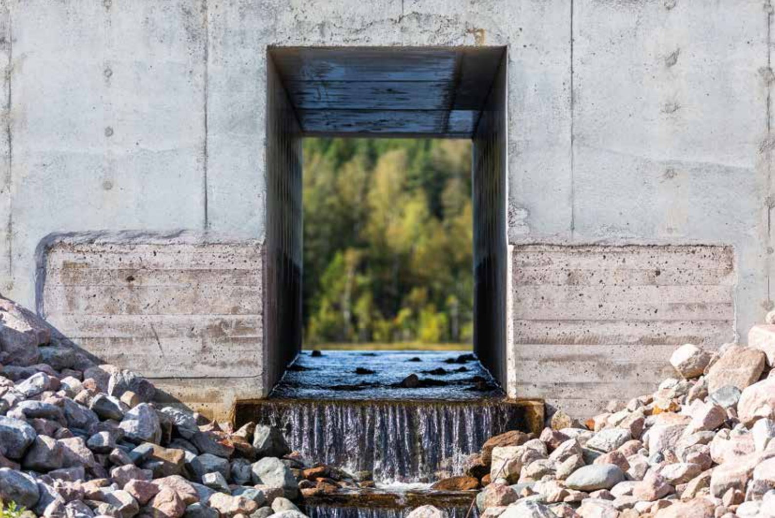
Detalj utskovskonstruktion med övervallströskel.
