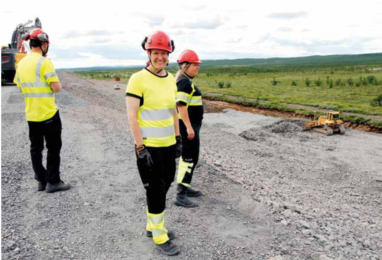
Pågående kapacitetshöjande åtgärder vid Kirunas gruvdammanläggning, LKAB.
