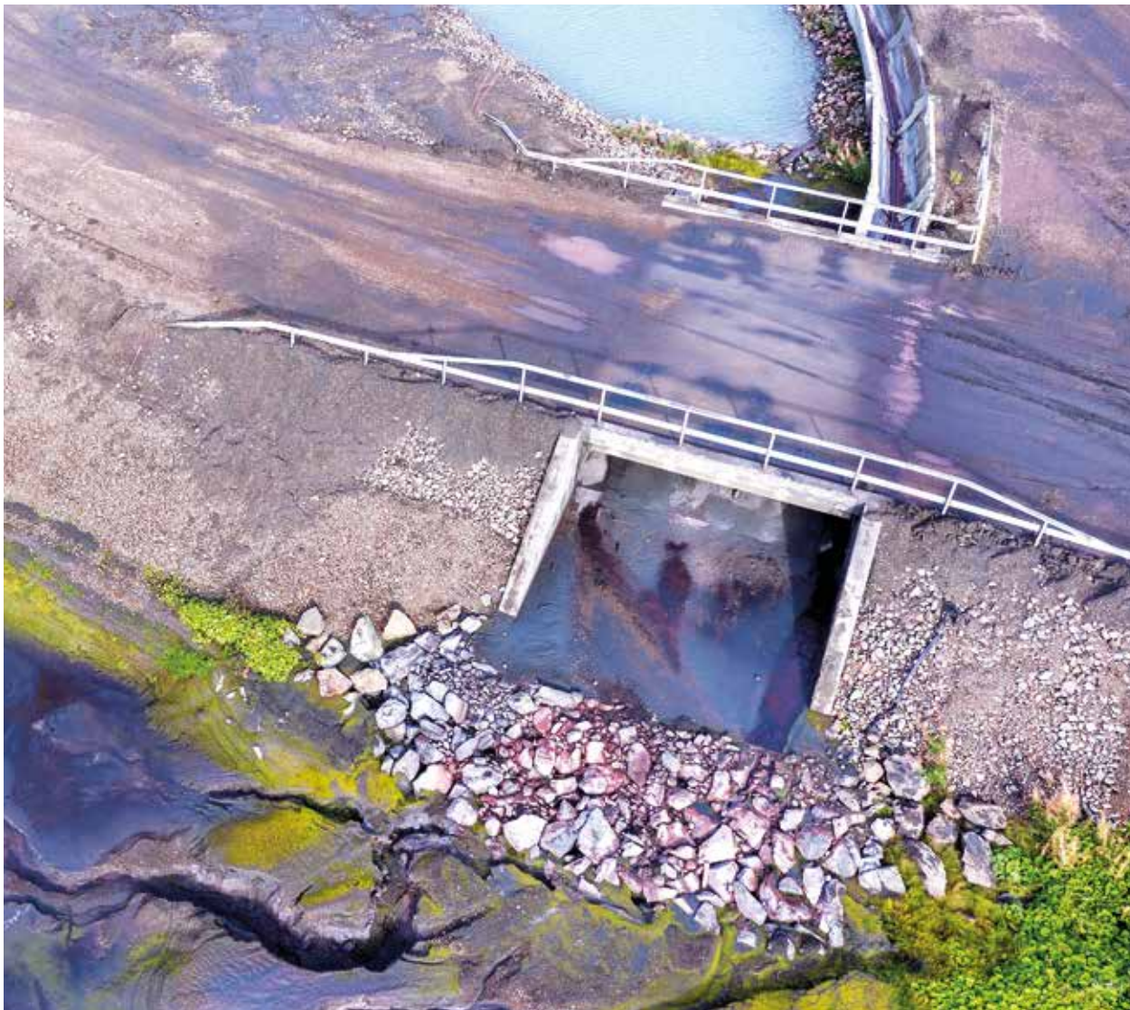
Detalj på utskovströskel mellan sedimentationsbassäng och klarningsmagasin, LKAB, Kiruna.
