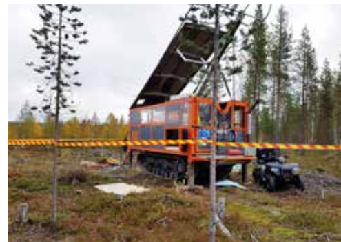
Kärnborrhållsmaskin i arbete. FOTO: GEOPOOL
