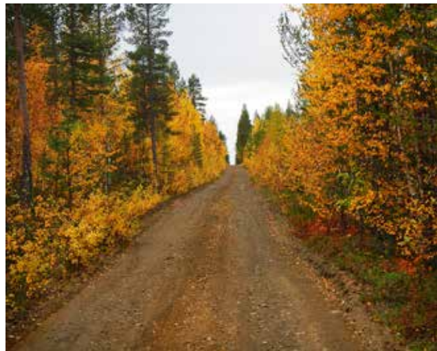
FOTO: GEOPOOL Samma väg efter återställning, hyvlad och påfylld.
