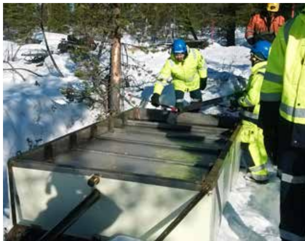
Mobil bassäng för sedimentation av borkkax.
