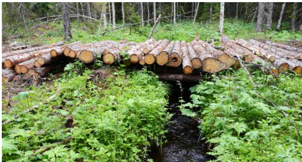
En stockbro kan byggas för att möjliggöra överfart över bäck eller dike.
