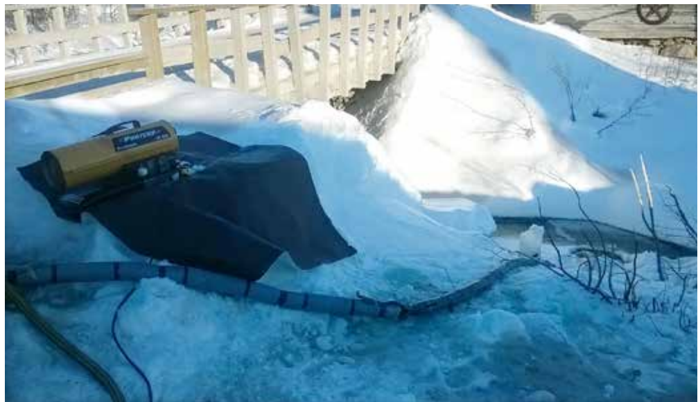
Pumpning av kylvatten från bäck till bormaskin.
