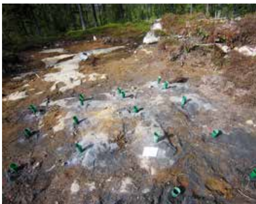
Sprängningsförberedelser inför provbrytning.
